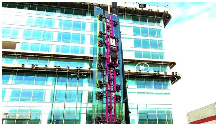
Монтаж цельностеклянной панели на фасад офисного здания
