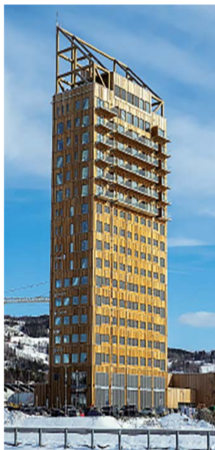
Рис. 5. Конструкция деревянной башни «Мьес» в Норвегии высотой 85,4 м
