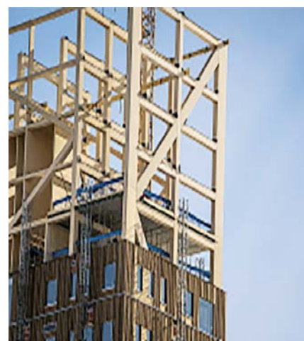
Рис. 5. Конструкция деревянной башни «Мьес» в Норвегии высотой 85,4 м
